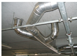
vyhřívaná vodovodní potrubí po instalaci topných kabelů
