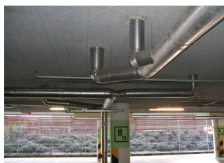
podstropní rozvody po instalaci topných kabelů
