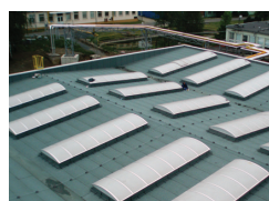
celkový pohled na střechu haly s oblémi světlíky
