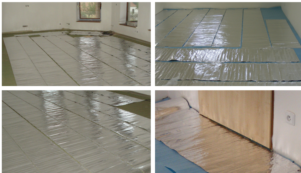
instalace topných rohoží HML na kročejovou izolaci, před pokládkou plovoucí podlahy
