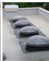
plochá střecha s hydroizolací
