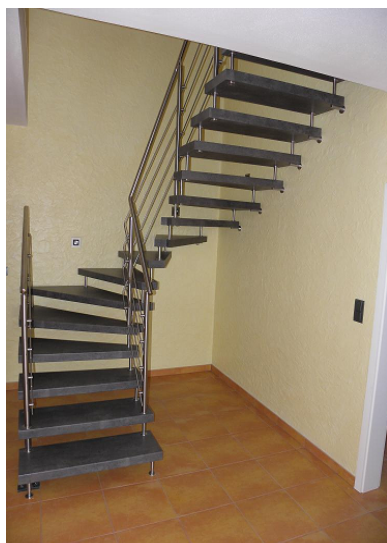
Pohled na celé schodiště
