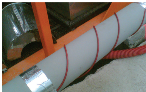
instalace topného kabelu na potrubí s asfaltem
