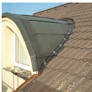
instalace topných kabelů u atypického střešního okna
