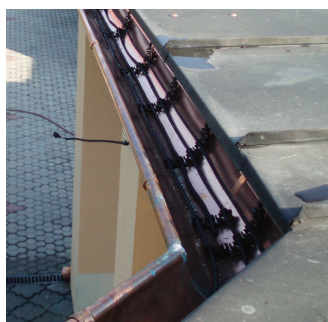
instalace topných kabelů v okapu
