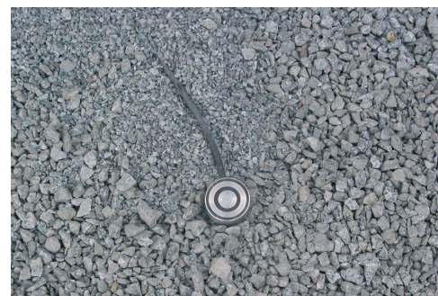
instalace vlhkostního čidla
